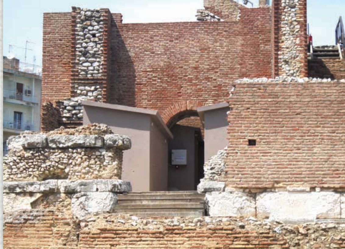
Το δυτικό παρασκήνιο με τις σύγχρονες ακαλαίσθητες κατασκευές πριν την έναρξη του έργου The western parascenium with the modern unfitting structures before the beginning of the project
