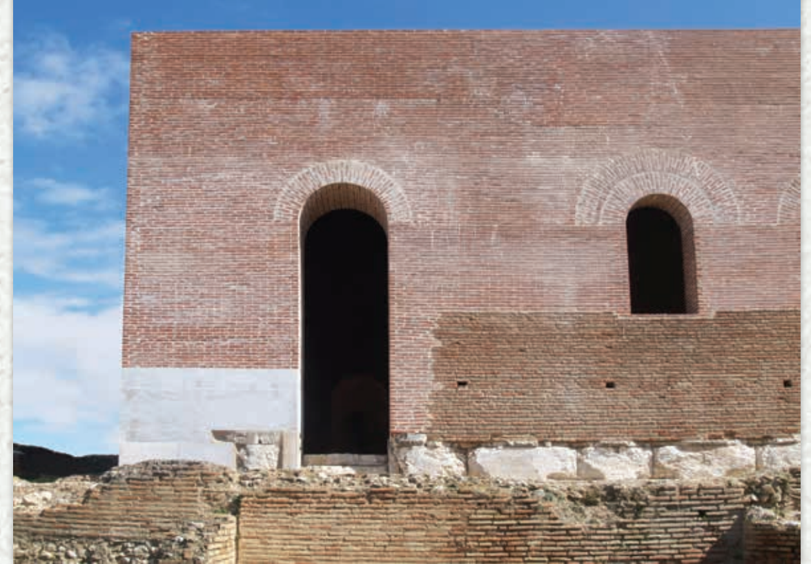
Το δυτικό παρασκήνιο μετά την ολοκλήρωση των αναστηλωτικών εργασιών The western parascenium after the completion of the restoration works
