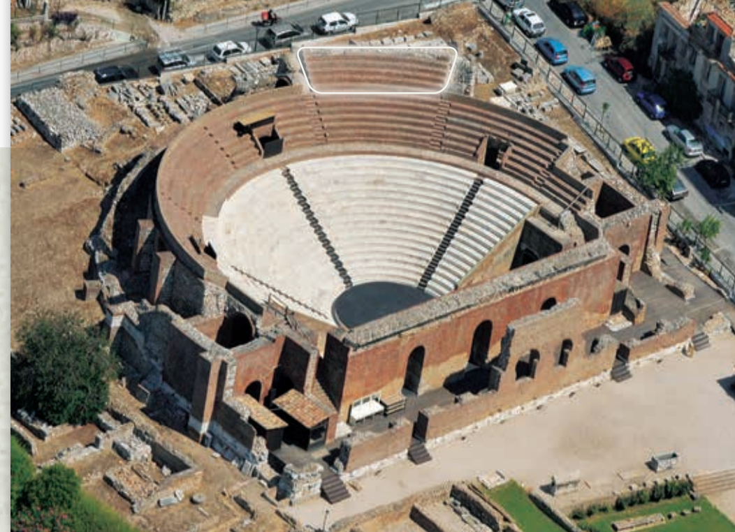
Το Ωδείο μετά την αναστήλωση του 1960. Προσθήκη τεσσάρων σειρών εδωλίων The Odeum after the restoration works of 1960. Addition of four rows of seats
