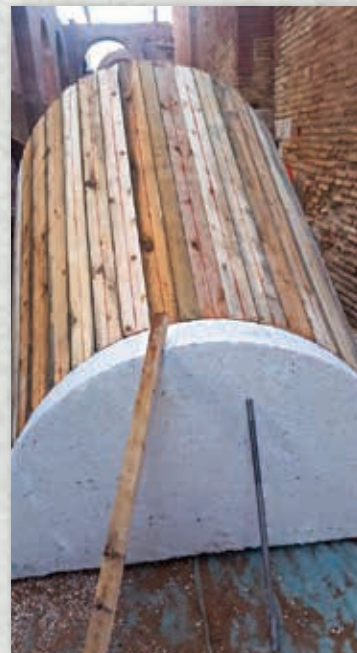
Δοκιμή ξυλότυπου μικρού θόλου Testing of a small vault mould
