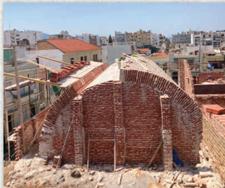
Φάσεις κατασκευής θόλων (φωτογραφίες από το εξωτερικό) Phases of vault construction (photos from exterior)
