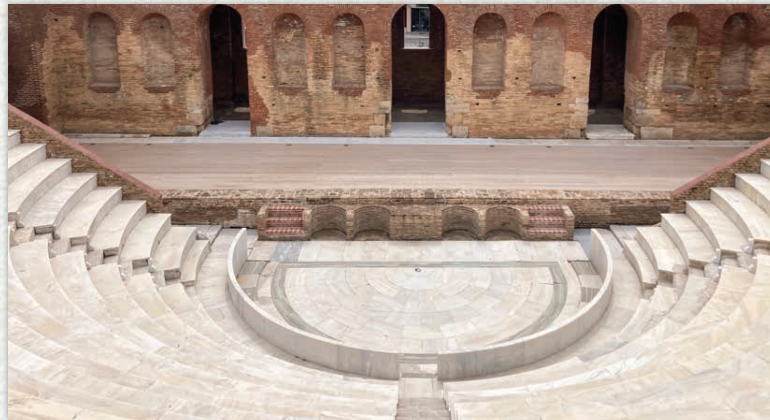
Προσκήνιο μετά την αποκατάσταση, ορχήστρα και κοίλο μετά τον καθαρισμό και τη συντήρηση των μαρμάρων Proscenium after the restoration, orchestra and cavea after the cleaning and conservation of the marbles
