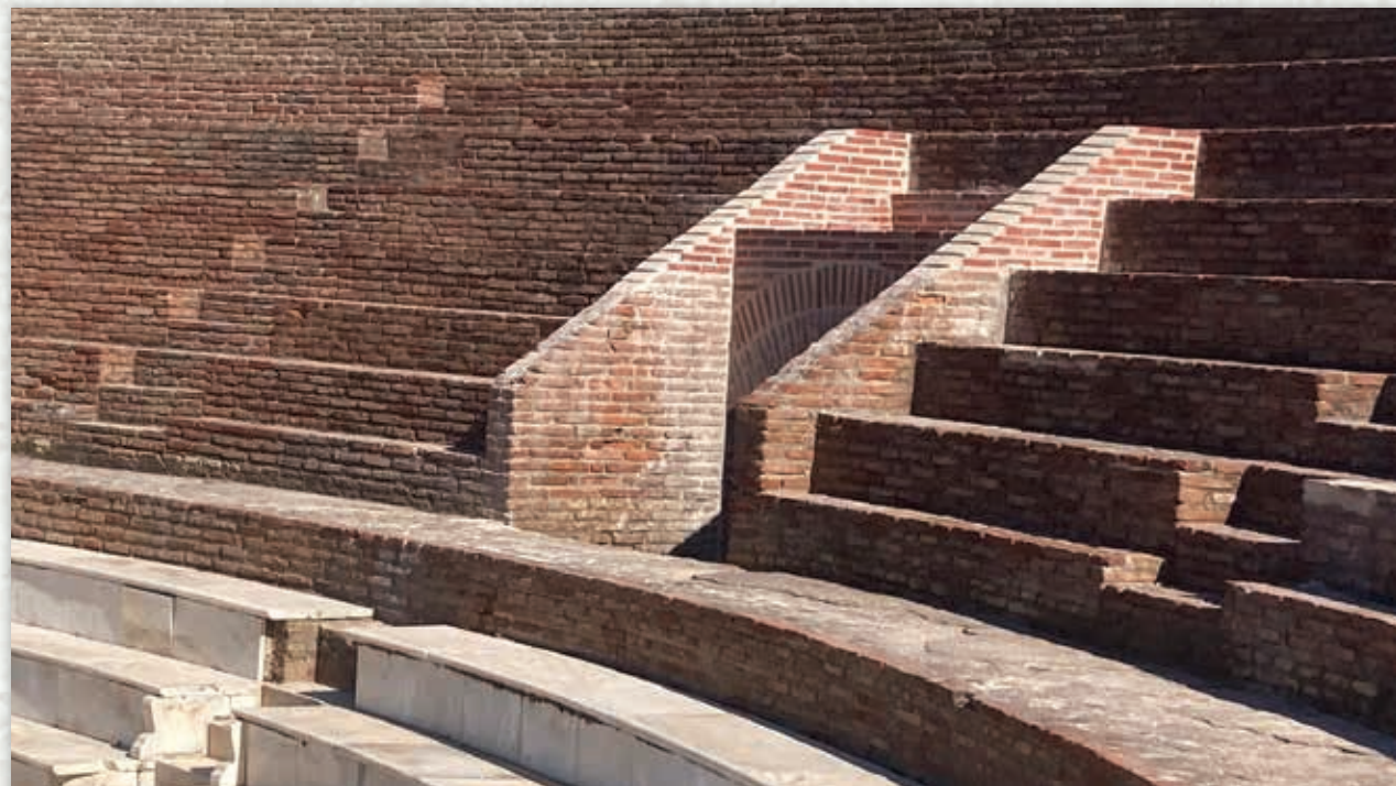
Βόρειο βομιτόριο. Αποκατάσταση στηθαίων και καμάρας Northern vomitorium. Restoration of the parapets and the vault.
