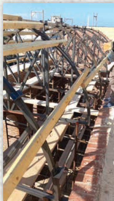
Καμπύλωση σανίδων ξυλότυπου μεγάλων θόλων Bending of planks for the construction of a large vaults mould
