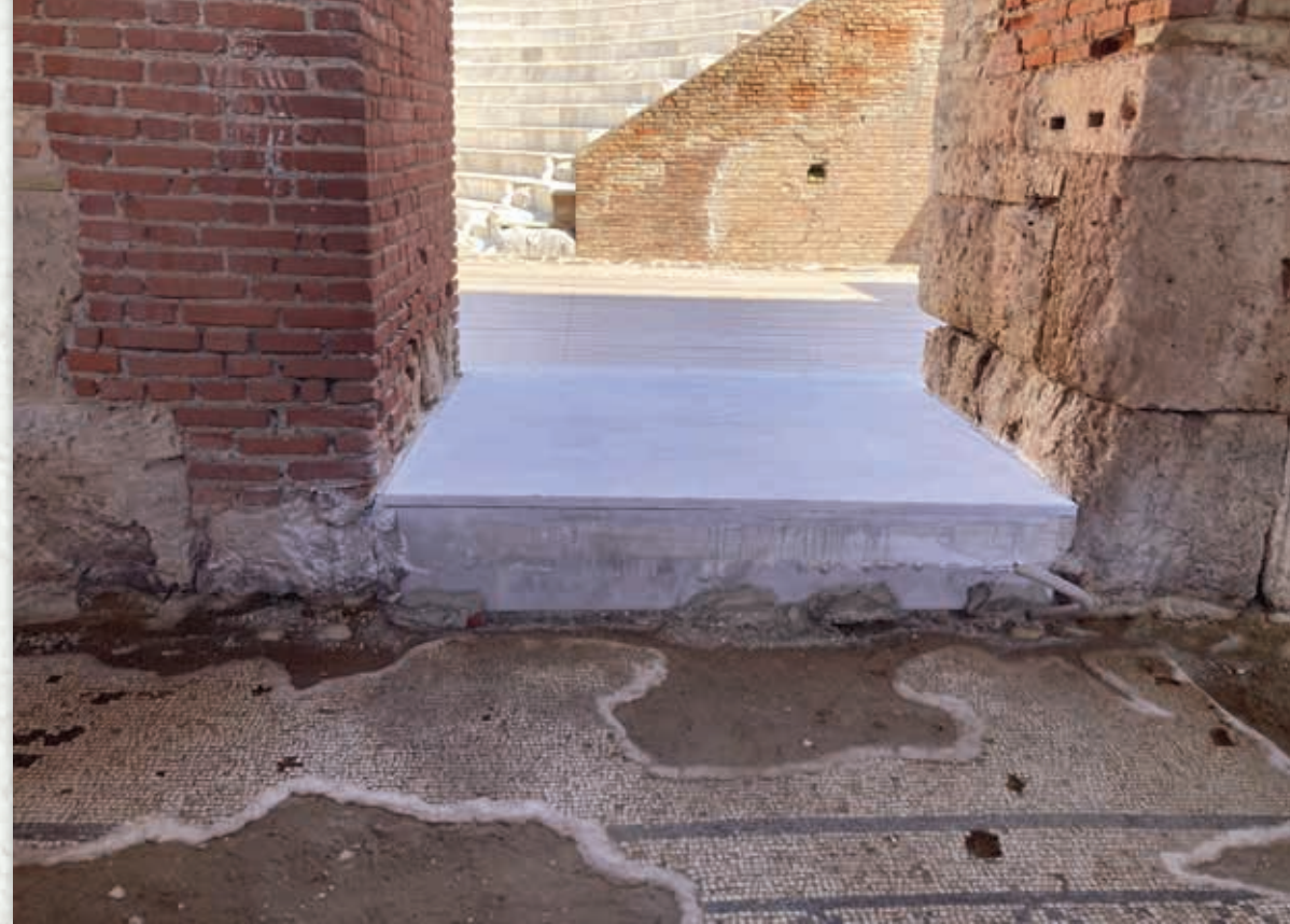
Το κατώφλι της ανατολικής θύρας της σκηνής μετά την αποκατάσταση The threshold of the stage's eastern door after the restoration
