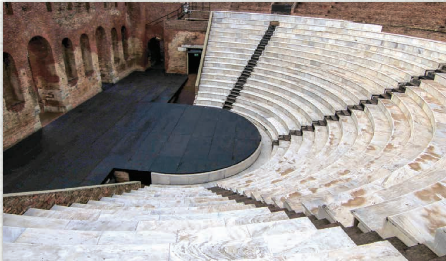
Προσκήνιο, ορχήστρα και κοίλο πριν την έναρξη του έργου. Proscenium, orchestra and cavea before the beginning of the project
