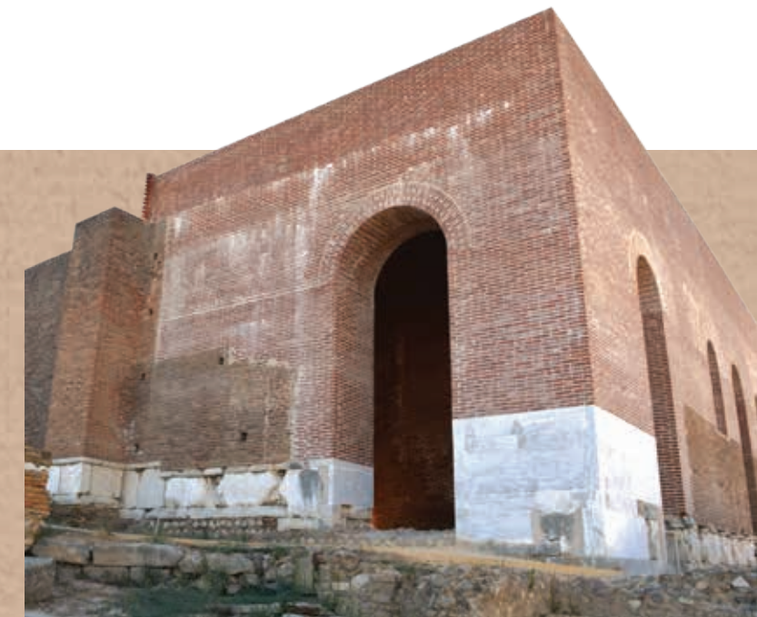
Το δυτικό παρασκήνιο μετά την αναστήλωση του 2023 The western parascenium after the 2023 restoration
