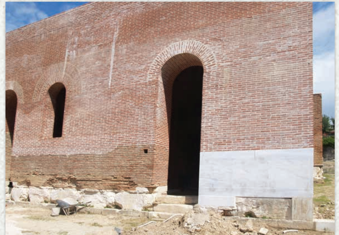
Το ανατολικό παρασκήνιο μετά την ολοκλήρωση των αναστηλωτικών εργασιών The eastern parascenium after the completion of the restoration works
