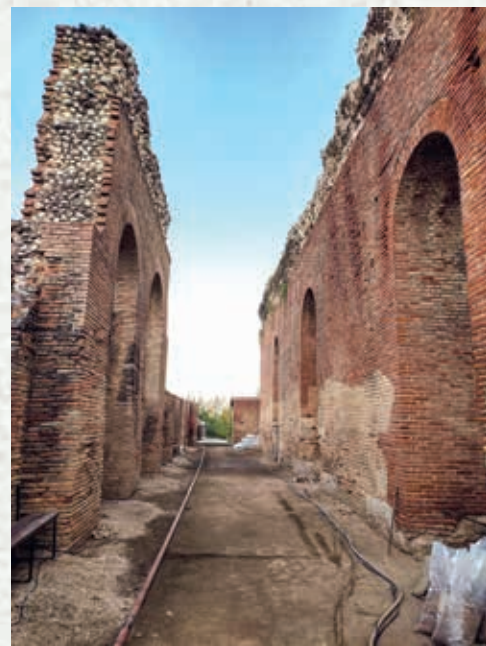
Η σκηνή του Ωδείου πριν και μετά τις αναστηλωτικές εργασίες The stage of the Odeum before and after the restoration works
