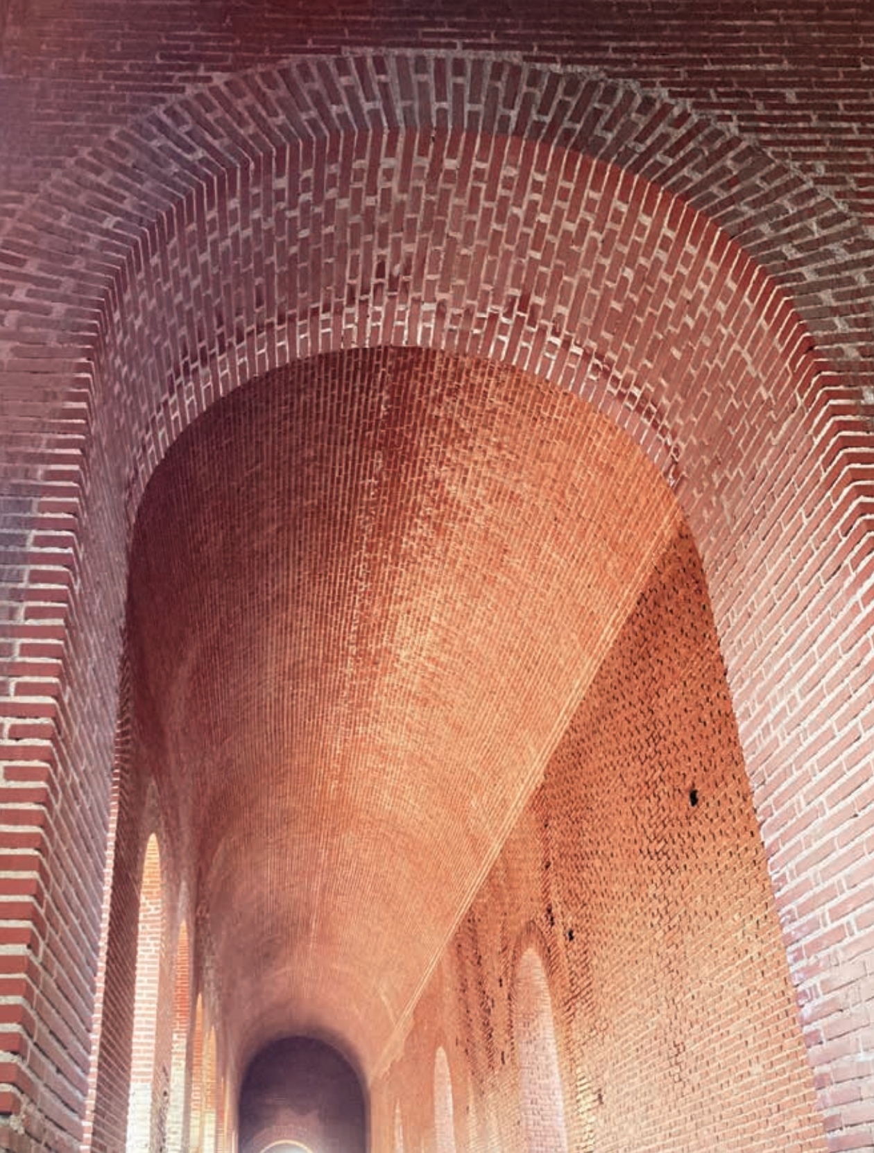
Ο θόλος της σκηνής μετά την αναστήλωση The vault of the stage (scene) after the restoration
