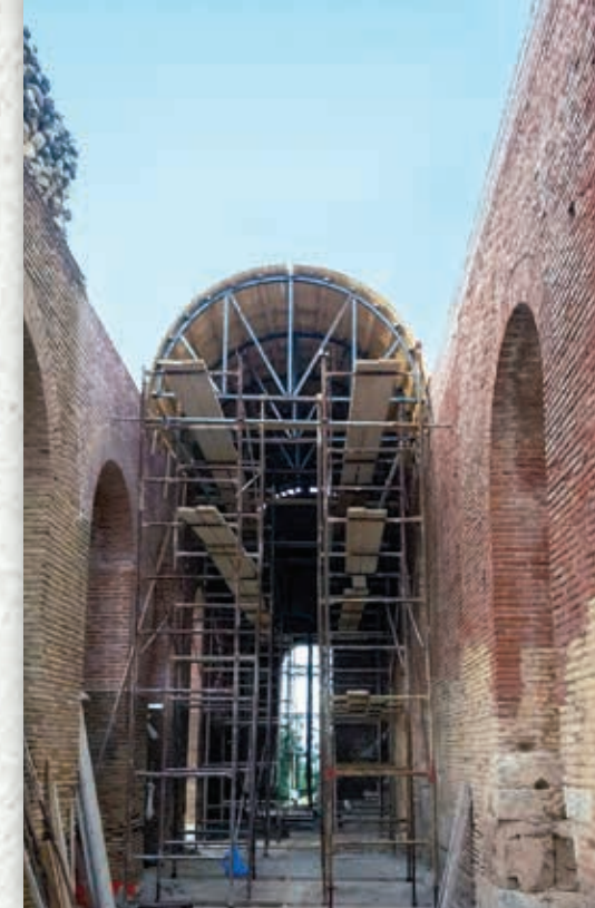
Θόλος σκηνής. Φάσεις κατασκευής (φωτογραφίες από το εσωτερικό) Vault of the stage. Phases of construction (photos from interior)
