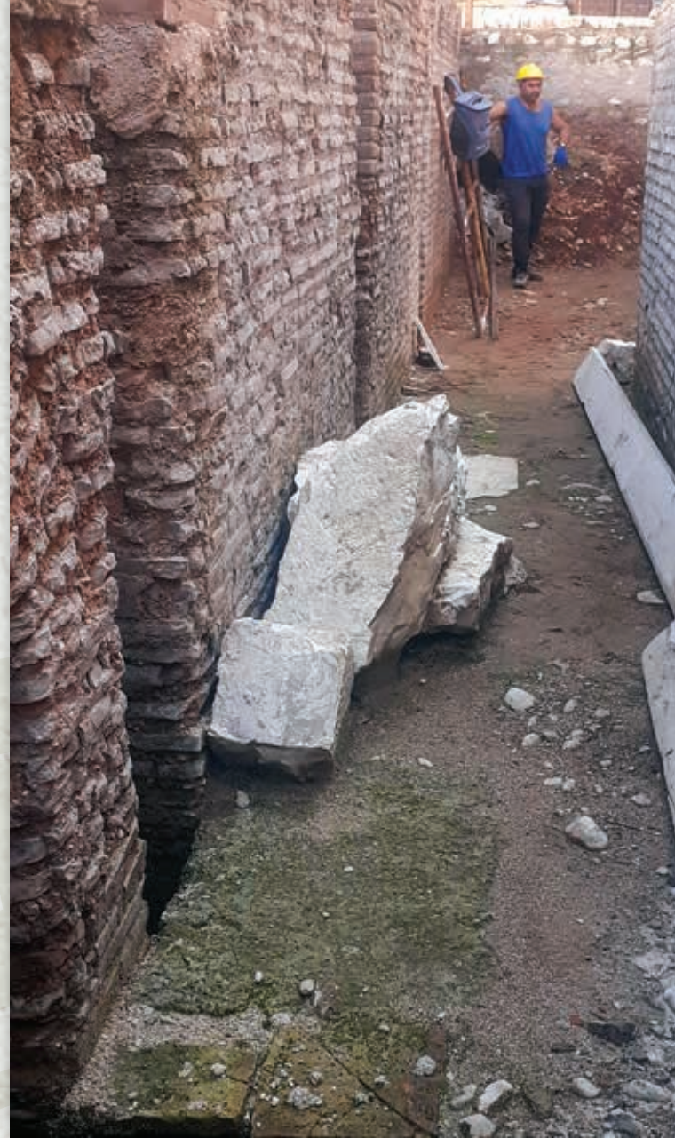
Λιθόπλακες από τον μηχανισμό της αυλαίας, στο δάπεδο της τάφρου Limestone slabs from the curtain mechanism found on the floor of the trench
