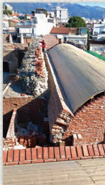
Φάσεις κατασκευής θόλων (φωτογραφίες από το εξωτερικό) Phases of vault construction (photos from exterior)
