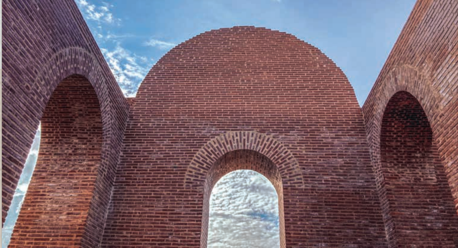
Αποκατάσταση κατακόρυφων τοιχοποιιών ανατολικού παρασκήνιου Restoration of vertical masonries of the eastern parascenium
