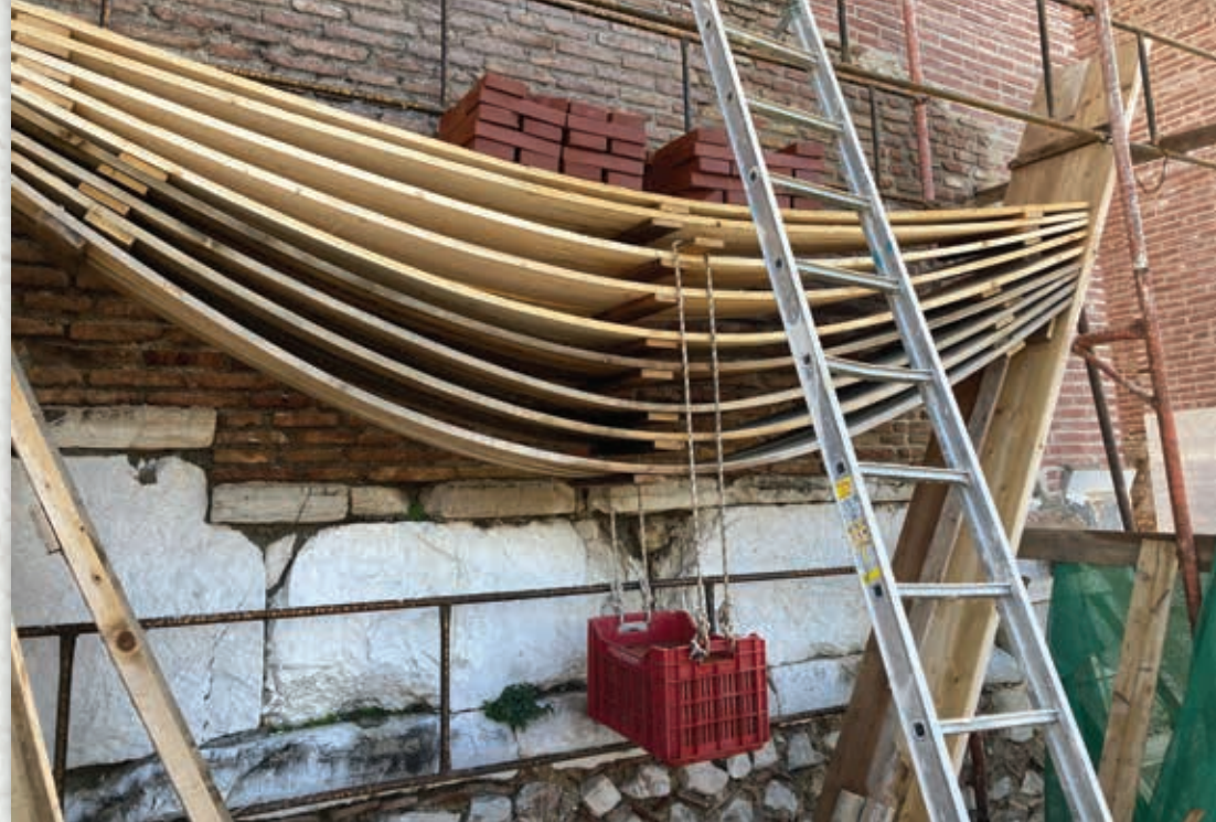
Καμπύλωση σανίδων ξυλότυπου μεγάλων θόλων Bending of planks for the construction of a large vaults mould
