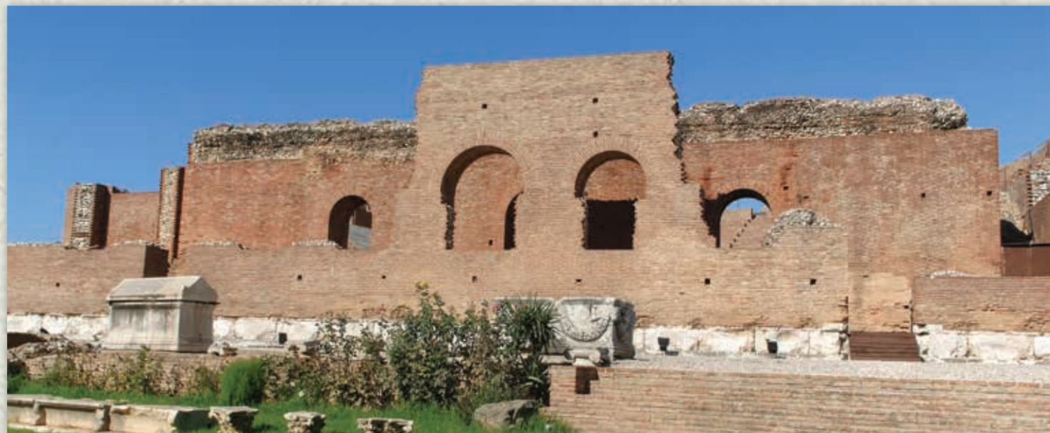
Παράθυρα του νότιου τοίχου της σκηνής πριν και μετά την αποκατάσταση
