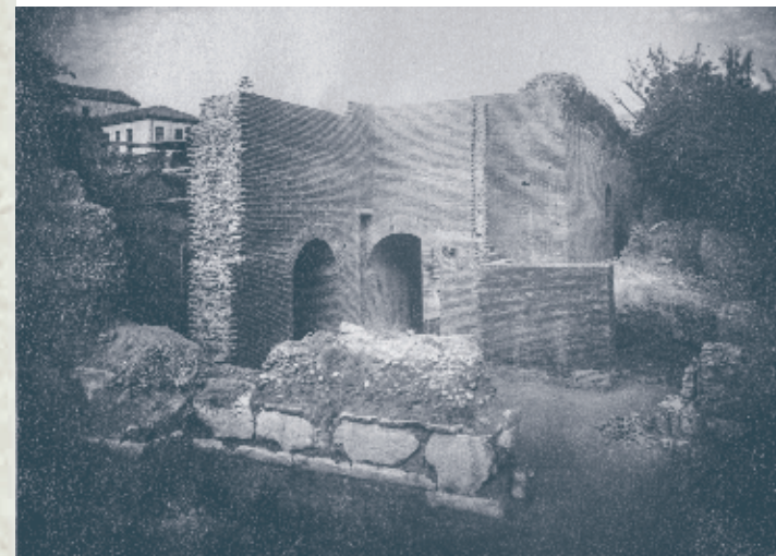
Το δυτικό παρασκήνιο μετά την αναστήλωση του 1960-61 The western parascenium after the 1960-61 restoration
