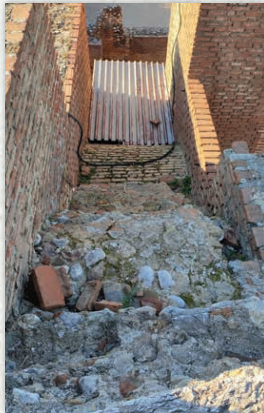
Η ανατολική κλίμακα της σκηνής πριν και μετά την αποκατάσταση The eastern staircase of the stage before and after the restoration
