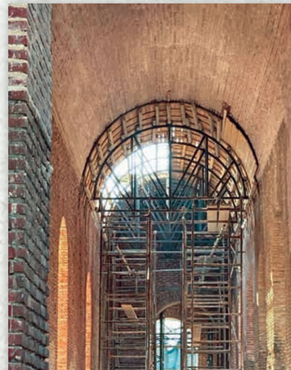
Θόλος σκηνής. Φάσεις κατασκευής (φωτογραφίες από το εσωτερικό) Vault of the stage. Phases of construction (photos from interior)
