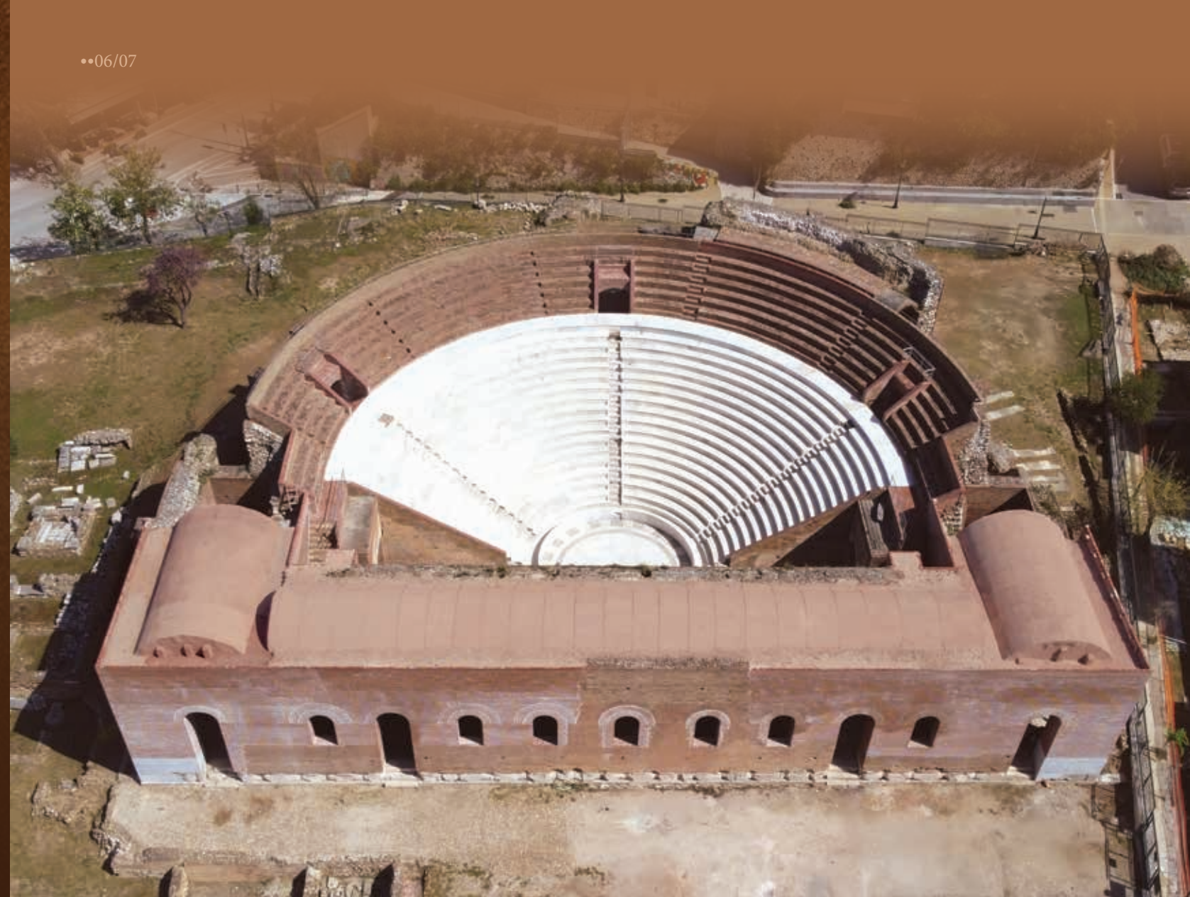
Το Ωδείο μετά την ολοκλήρωση της αποκατάστασης The Odeum after the completion of the restoration
